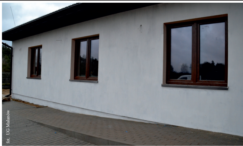
Budynek świetlicy Celestynach
